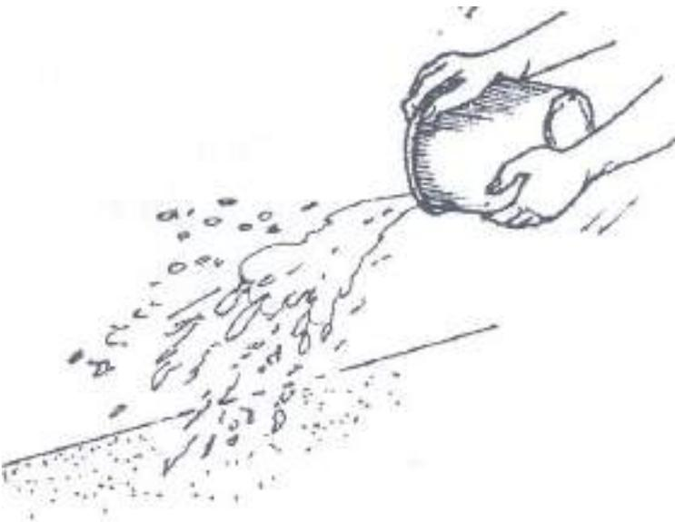
14. Después de fundido los elementos de concreto, vigas, columnas, paredes repelladas y finos, se “curan” echándole agua tres veces al día, al menos durante siete días.
